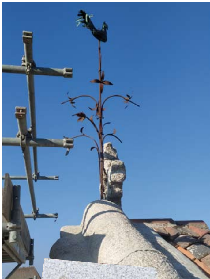
Démoussage et rejointement du fronton vus du haut des échafaudages (7 mars 2022)
